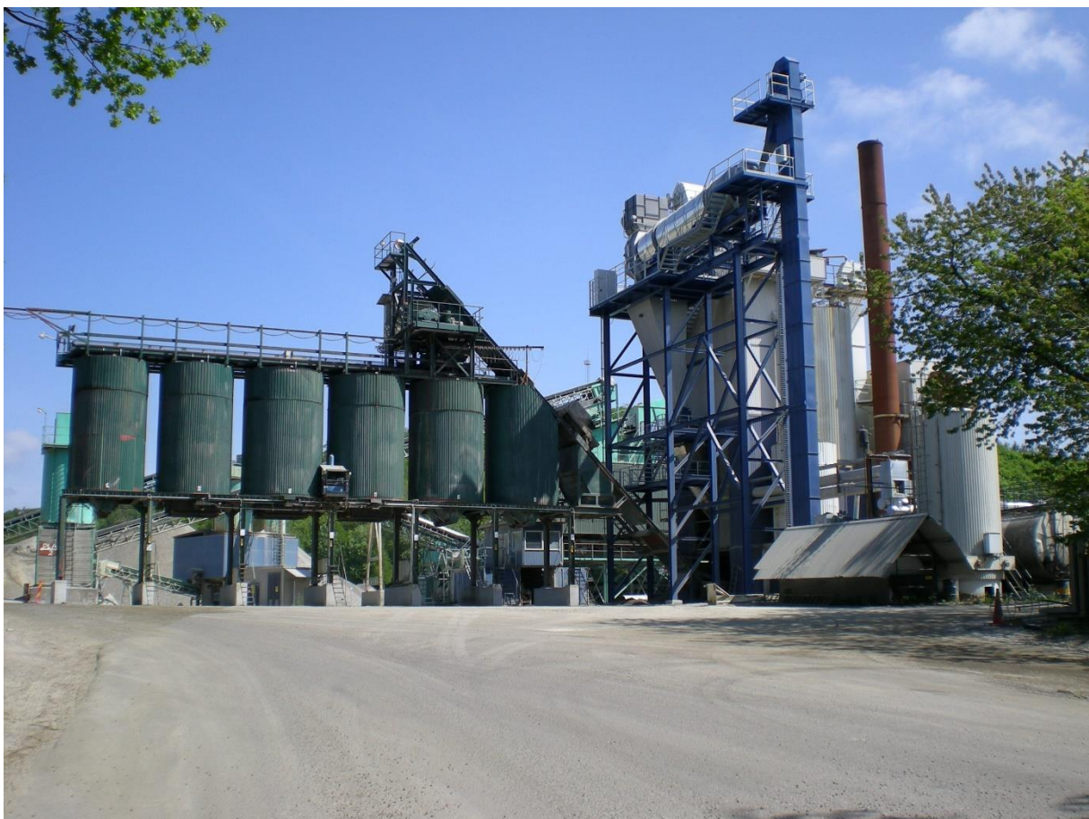
Figur 3.5.1 Asfالتverket i Valinge. I Valinge är matningen av bergmaterial automatiserad och elektrifierad, från krossen till asfالتverket och fungerar som en enhet.
