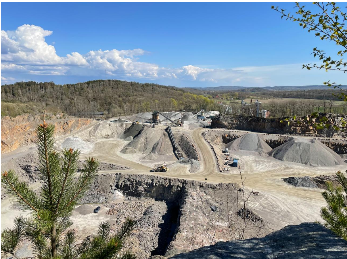
Figur 3.2.1 Pågående verksamhet med körvägar och lastning vid materialupplag.
