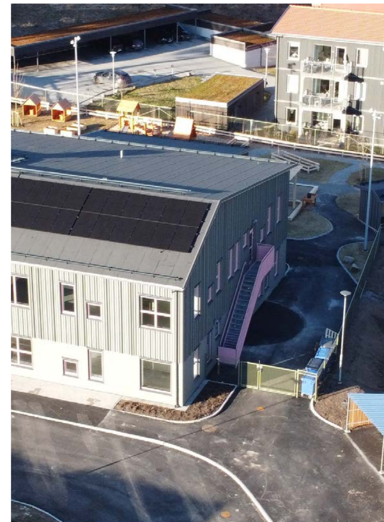
Energibesparande solceller på taket är ett tillval som är enkelt att göra när du beställer en ABCD-förskola.
